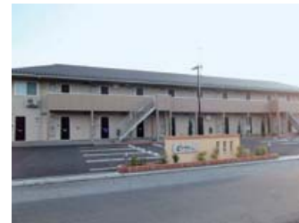
従業員寮 武川寮（埼玉工場）
