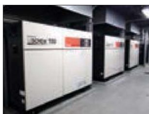
1機に2台の圧縮機が搭載されているインバーターエアコンプレッサー
