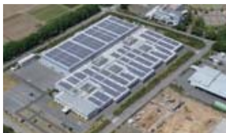
埼玉工場太陽光発電所
