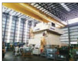
工場天井と壁面の明り取り窓
