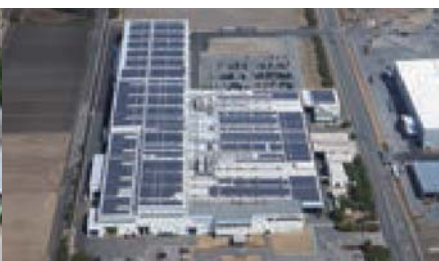
群馬工場太陽光発電所
