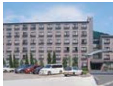
従業員寮 高徳寮(滋賀工場)
